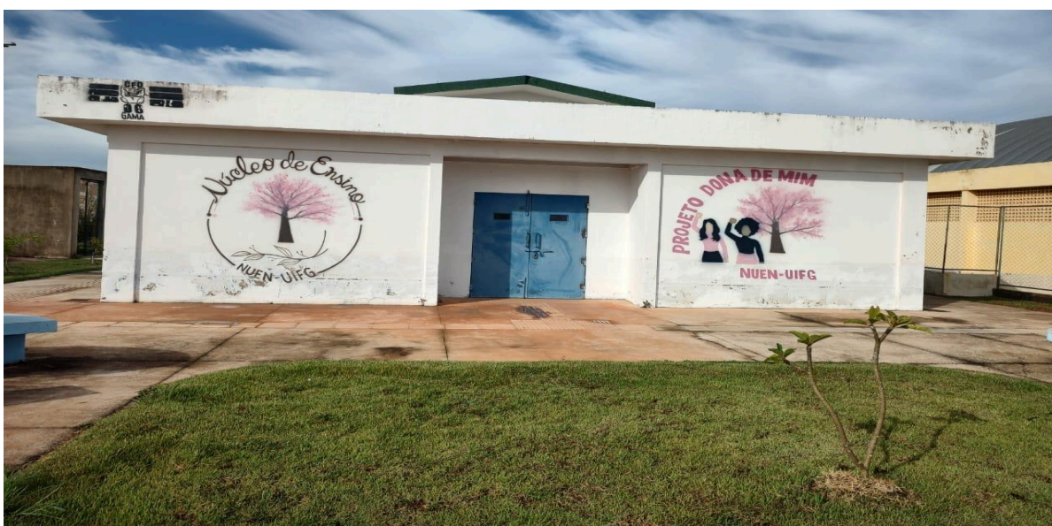
Foto atual – 01- Fachada externa do NUEN
