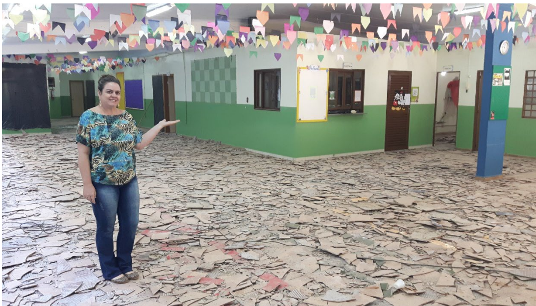
Troca do piso de toda a escola em 2016
