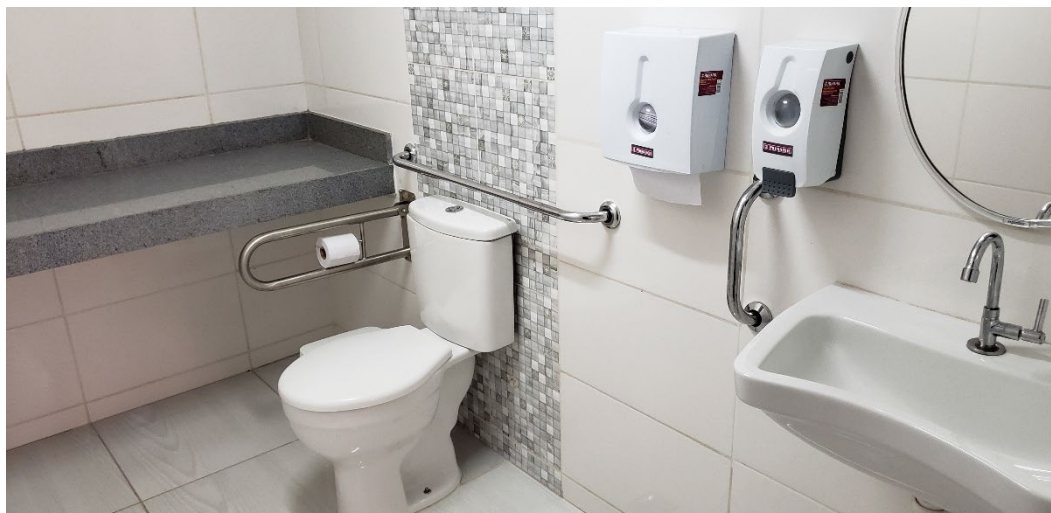
Reforma do banheiro adaptado em 2018
