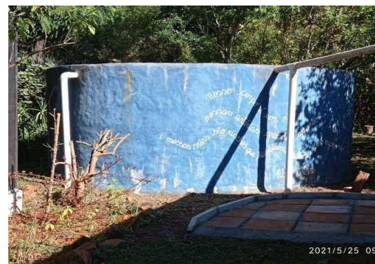
Tanque de Captação de Água da Chuva
