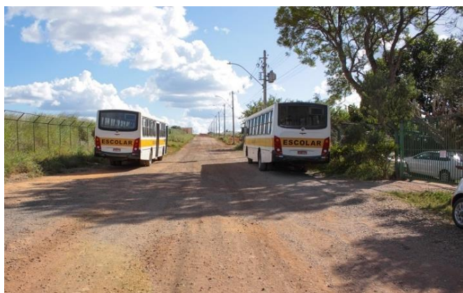
Figura 2. Estrada de acesso à escola antes do asfalto
