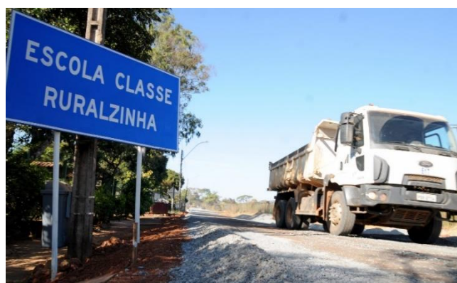
Figura 3. Pavimentação da via de acesso à escola.
