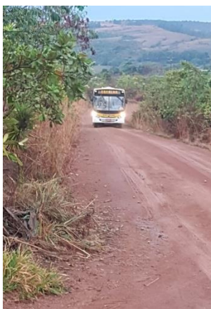
Imagem 38: Estrada que dá acesso à escola em dias sem chuva.
