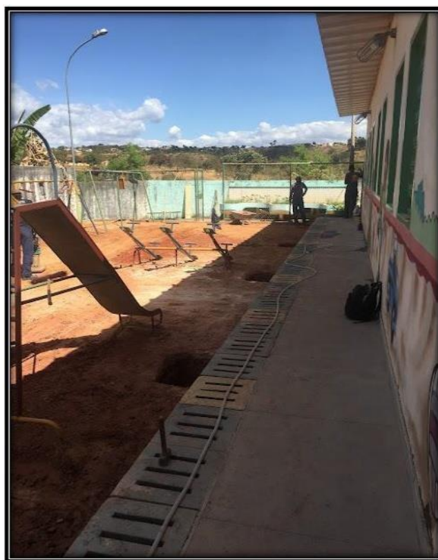
Parque sendo reformado, em 2021.
