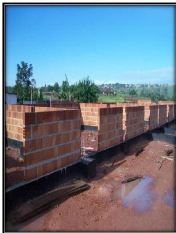
Início da reconstrução da Escola
