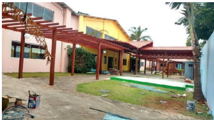
Figura 3: Edifício sede da CAP, em obras de reforma e adequação.
