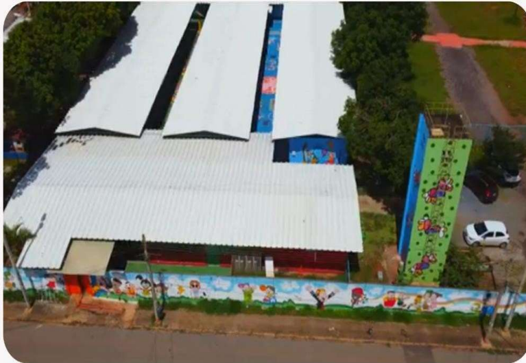
TROCA DO TELHADO DA ESCOLA
