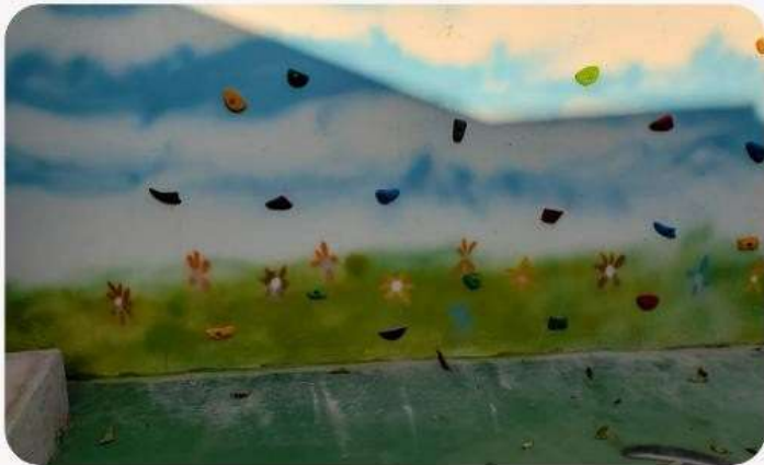
CONSTRUÇÃO DA ÁREA DE CONVIVÊNCIA
