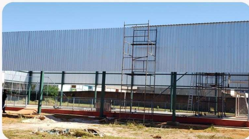
COBERTURA DA QUADRA DE ESPORTES
