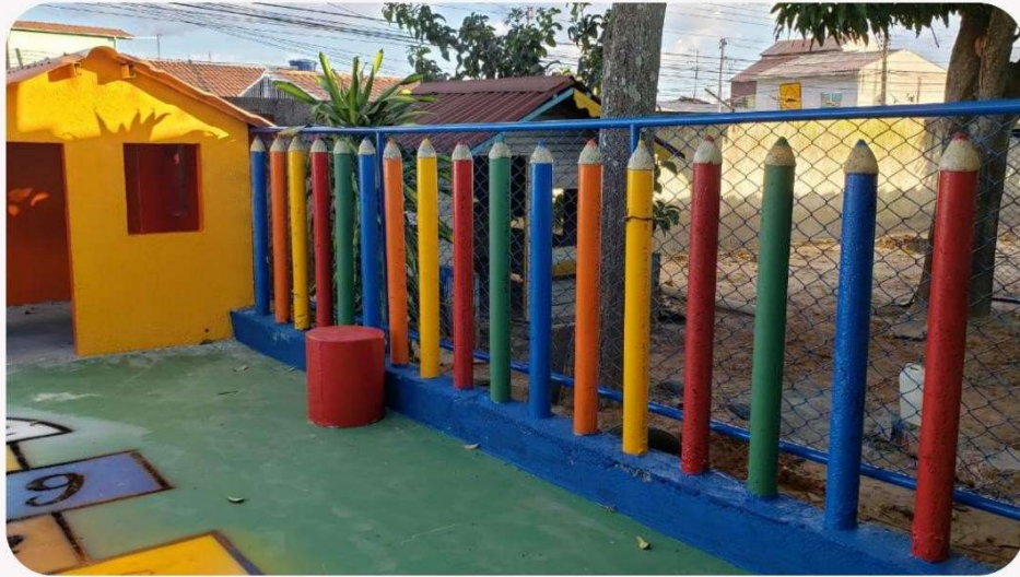
CONSTRUÇÃO DA ÁREA DE CONVIVÊNCIA
