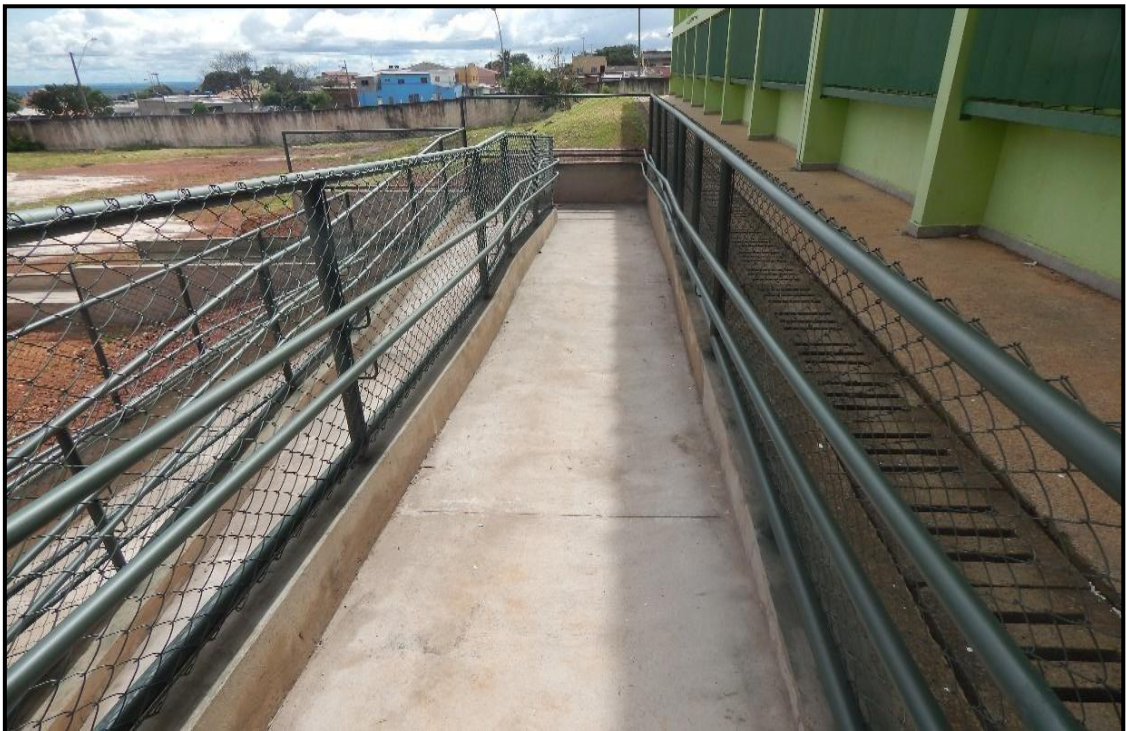
Rampa de acessibilidade
