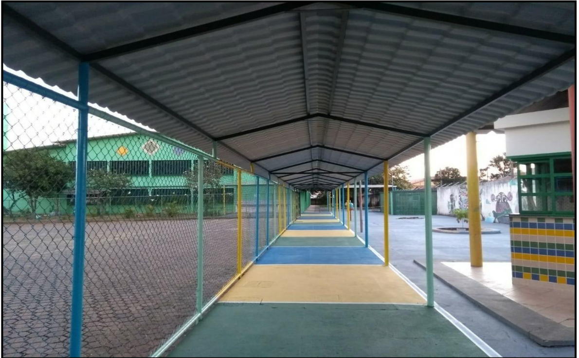
Entrada coberta para pedestres
