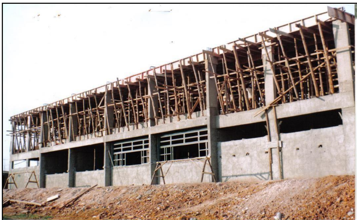
Vista do CRA - Escola Classe 501 de Samambaia - DF, em construção, 2005
