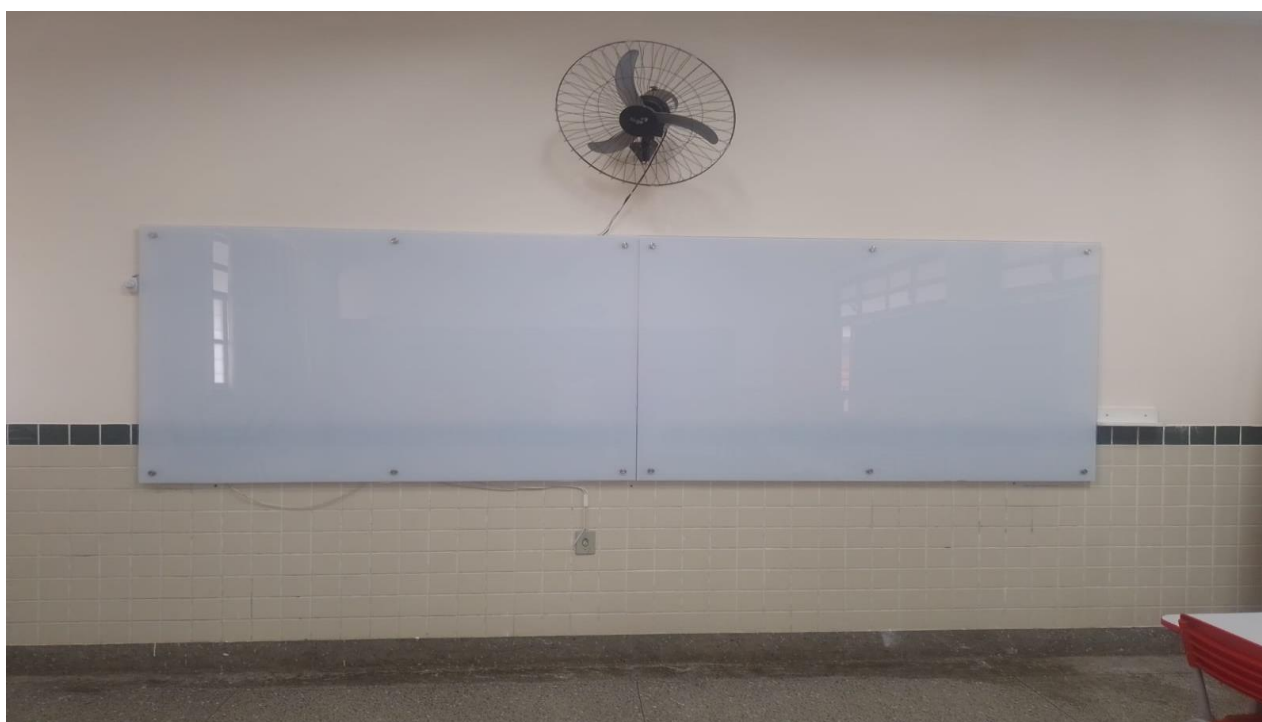
Instalação de lousas de vidro em todas as salas e aula em 2023.
