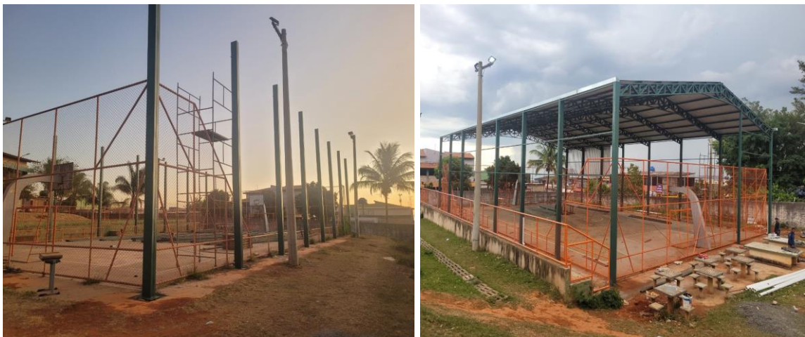
Obras de cobertura da quadra em 2022
