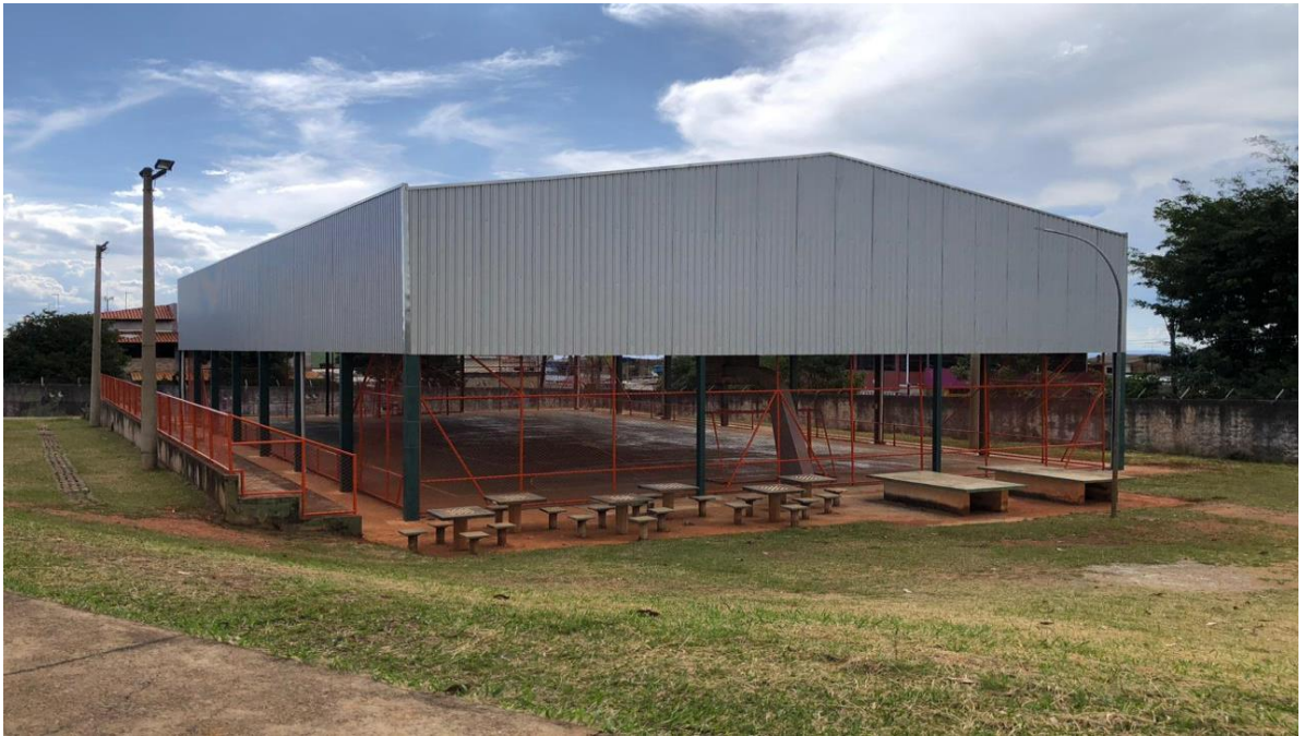
Obra de cobertura da quadra finalizada e entregue em 2022.
