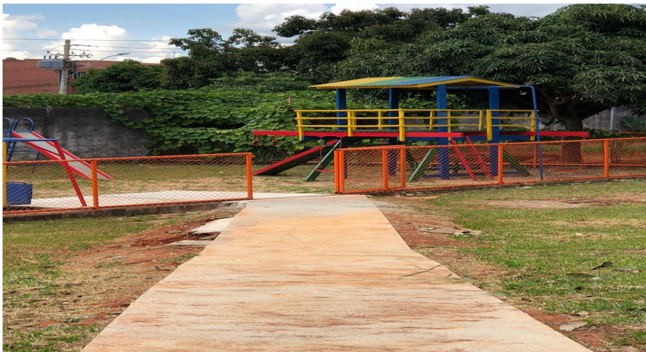
Construção de nova rampa de acesso ao parque em 2022.
