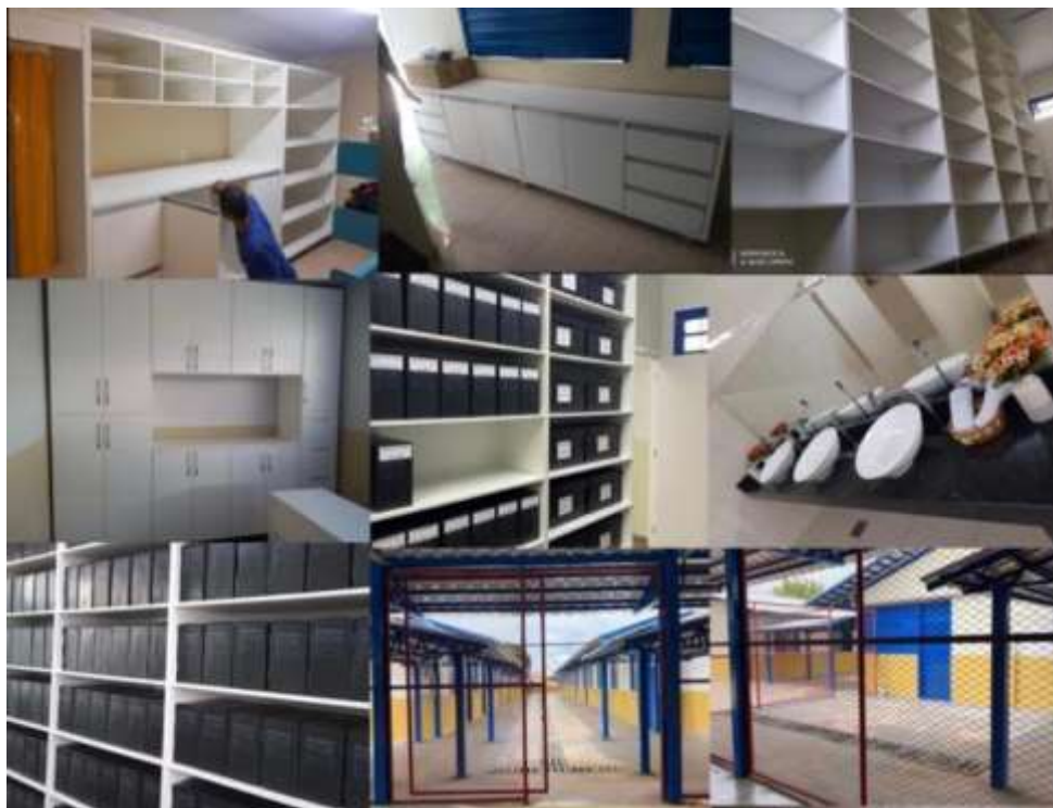
Mobiliário planejado, pintura interna e externa da escola
