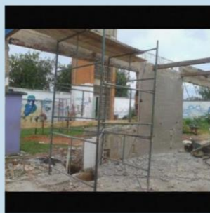
Antes da Reforma
