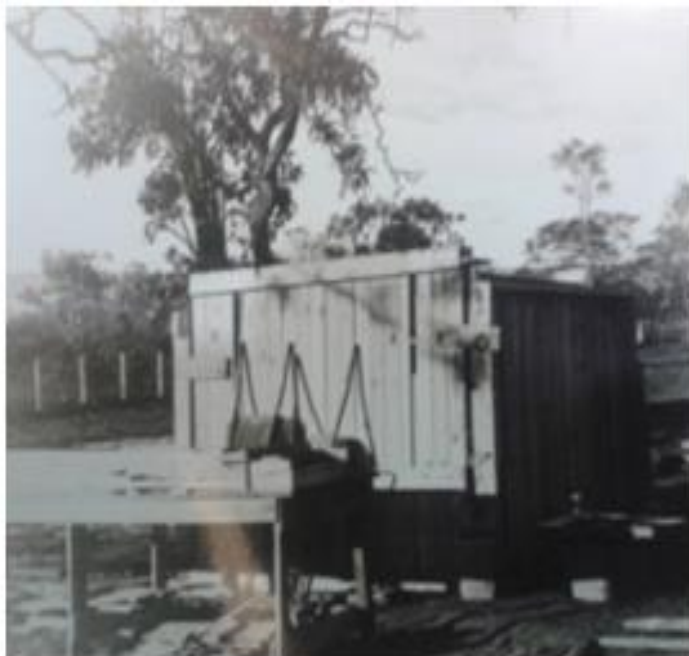
(Início da construção da sede da Instituição)
