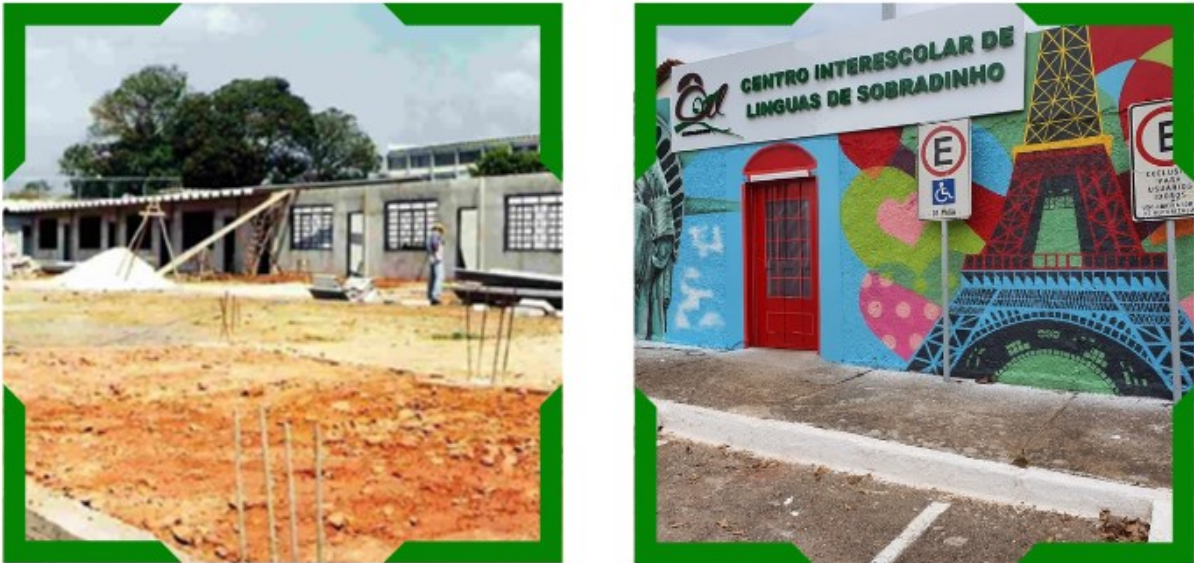
Figura 1 – Construção da sede do CIL de Sobradinho e estrutura atual da escola.
