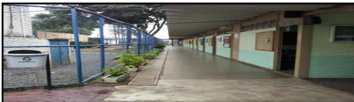
Figura 9 – Corredor salas de aula CILG até 2021
