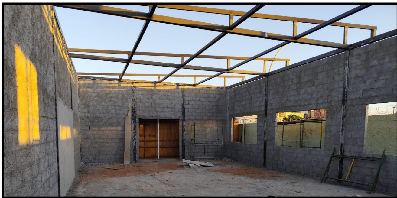
Figura 25 – Auditório do CILG em construção (maio de 2024)
