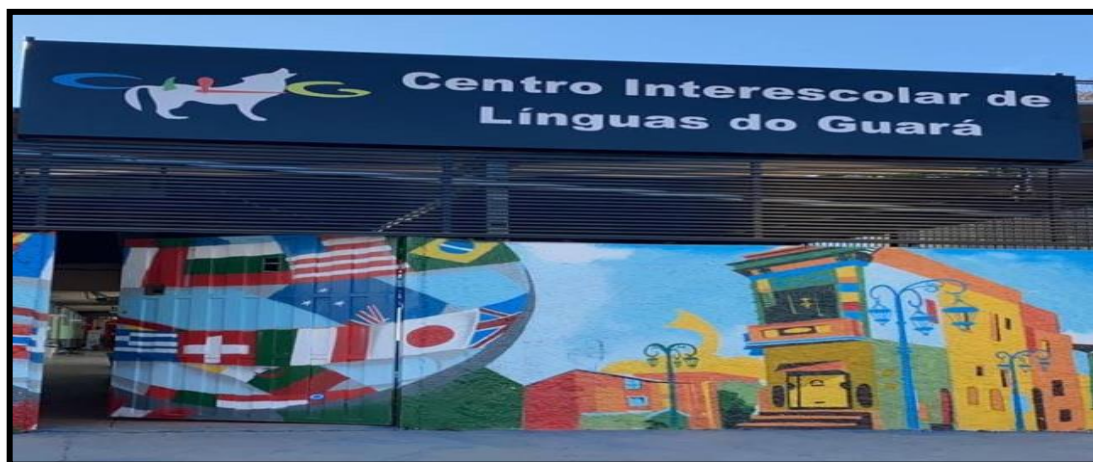
Figura 8 - Fachada CILG atual
