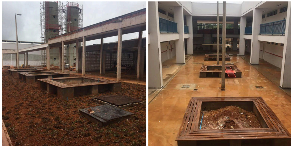
Imagens da Construção da Escola 2019
