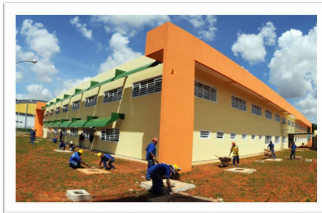
HOMENS TRABALHANDO NA CONSTRUÇÃO DA ESCOLA - 2008
