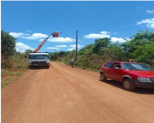
Instalação de novos padrões de energia.
