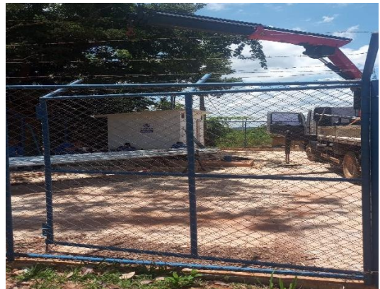
Instalação de novo poço artesiano da CAESB.
