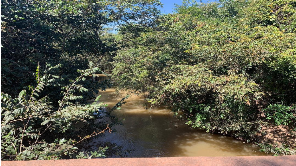
Ponte sobre o Rio Jardim, no Núcleo Rural Sussuarana (2019)
