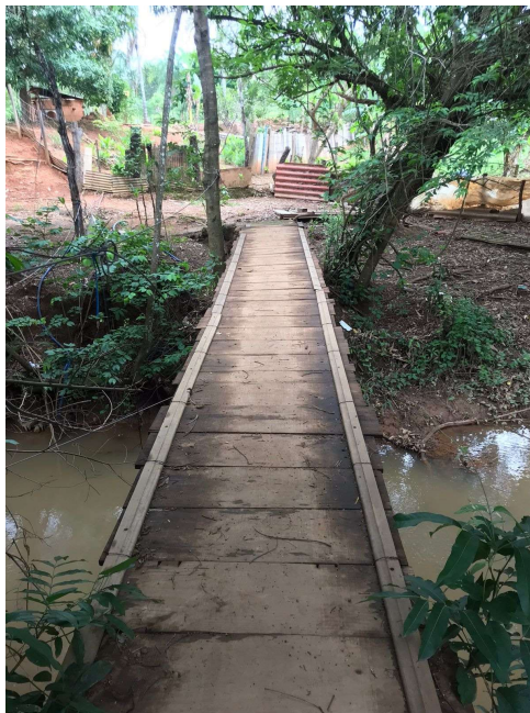
Pequena ponte “pinguela” utilizada pela comunidade.
