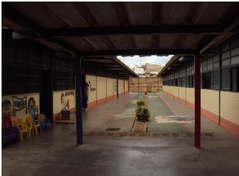
BLOCO ADMINISTRATIVO DO CEI 307- 2013
