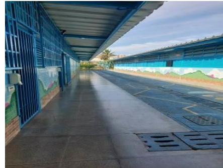
BLOCO ADMINISTRATIVO DO CEI 307- 2024
