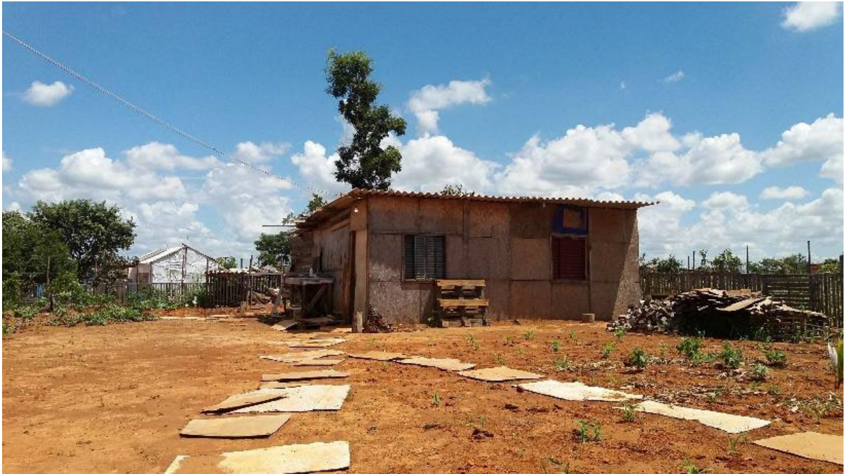
(Figura 27 – Foto de moradia de madeira no Acampamento)
