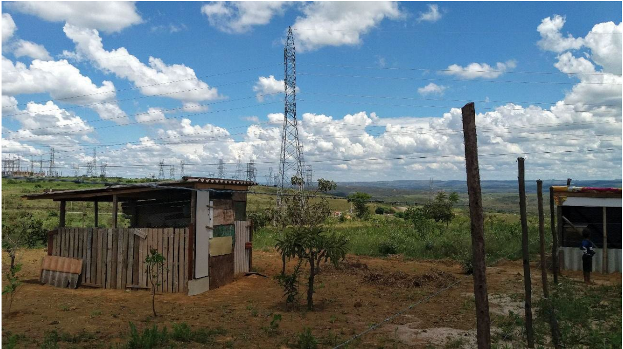
(Figura 33 – Foto das linhas de transmissão de Furnas)
