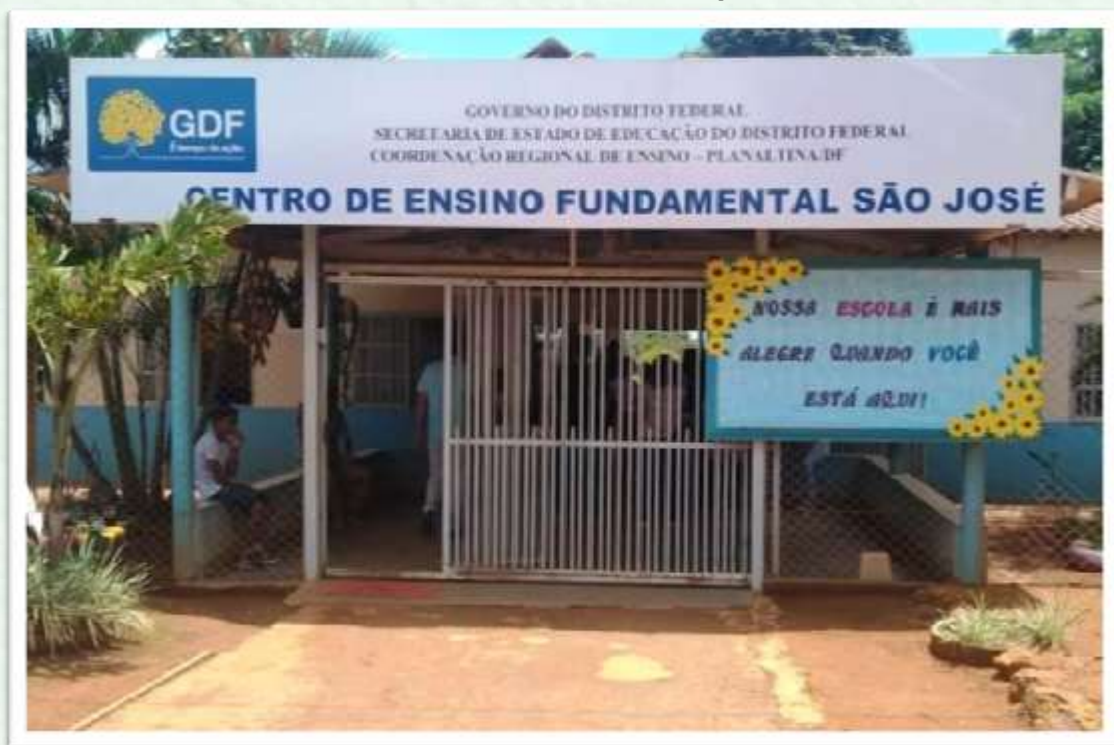
Fig. 1. Fachada da Escola em 2020
