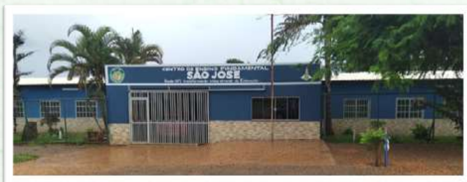
Fig. 7. Fachada da Escola em 2022
