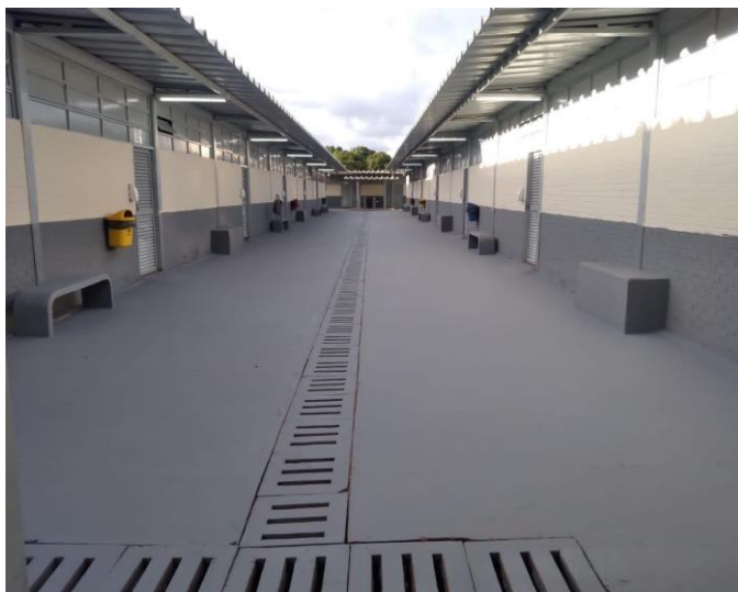
Blocos de salas de aula/corredor
