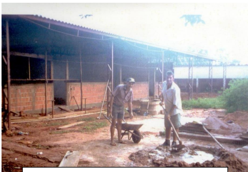
Fotos do novo prédio em construção – início/2000
