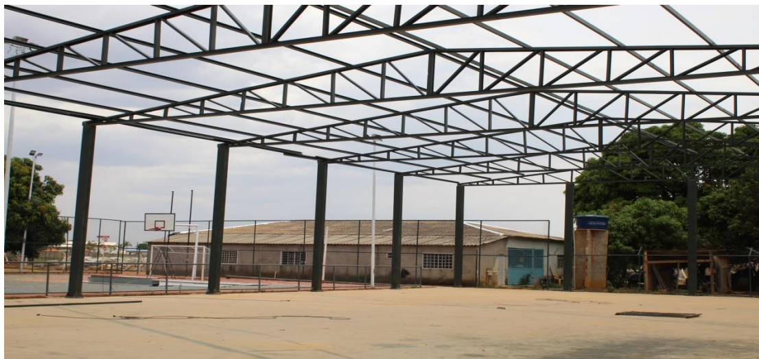
Obras de cobertura da quadra escolar do CED PAD-DF, com intuito de adequar espaços para receber a comunidade em eventos culturais, bem como promover eventos internos de modo mais confortável e seguro, 2022.
