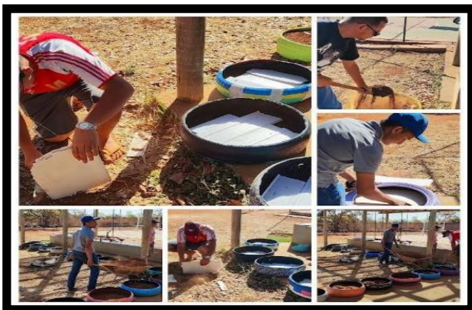
Foto 8: Corte de forro PVC
