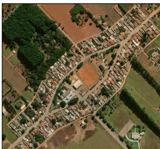
Figura 30 - Vista aérea do CAUB I na atualidade
