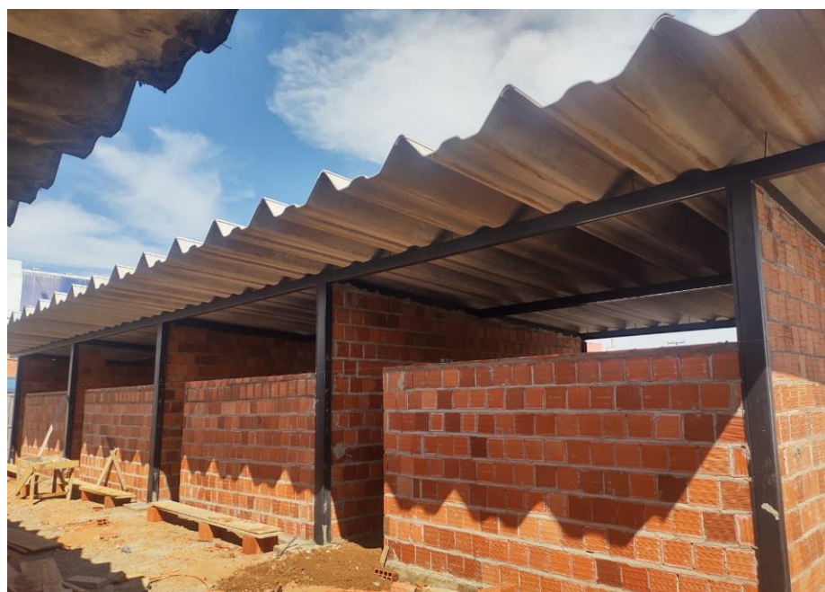
Figura 8 – Construção salas CILG (2)
