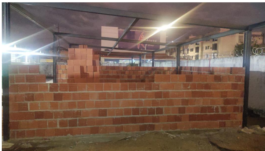
Figura 7 – Construção salas CILG (1)
