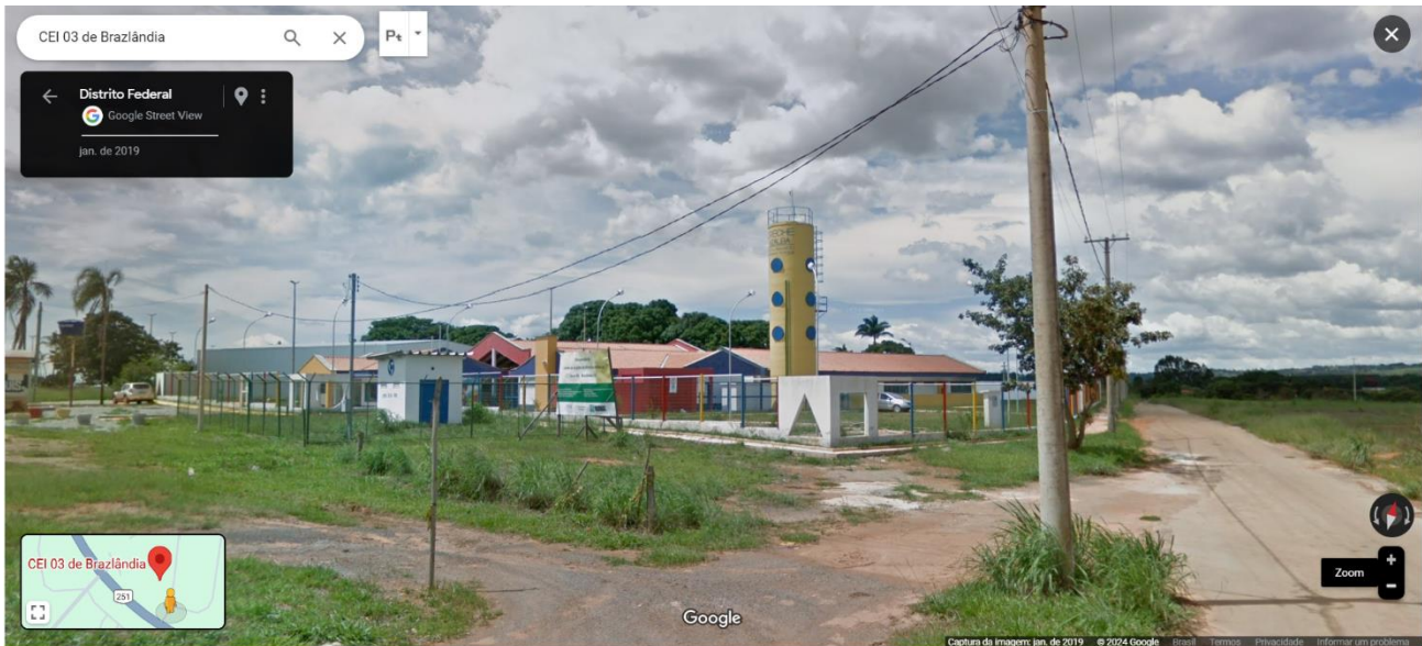
Figura 17- Imagem da escola quando o prédio ainda tinha a pintura "Creche Azaleia" na caixa d'água
