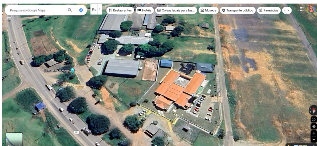
Figura 14- Vista aérea do CEI 03 de Brazlândia (Fonte: Google Maps em 18/06/2024)
