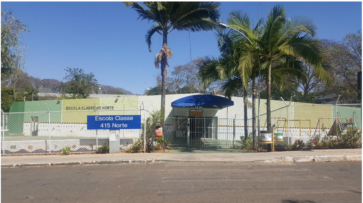
Imagem 01: fachada da escola
